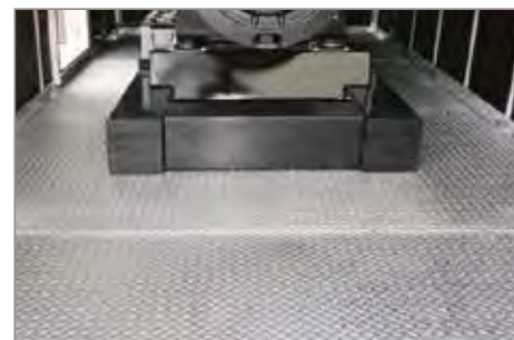
▲ Pavimentazione interna in lamiera zincata mandorlata
