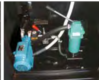
▲ Kit di riempimento automatico del gasolio composto da: pompa elettrica automatica, pompa manuale d'emergenza, raccordi esterni per tubazioni, centralina elettronica di gestione, sensori a 4 livelli, valvola deviatrice
