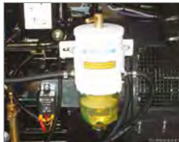
▲ Filtro separatore acqua tipo Racor
